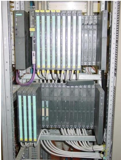
Blick in einen Schaltschrank mit S7-1516 CPU und ET200 SP (003)
