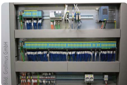
Bild 3: Blick in einen Schaltschrank mit S7-1516 CPU und ET200 SP
